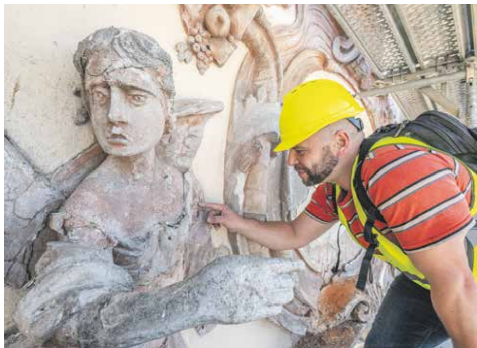
Stavbyvedoucí Aleš Taufar v první fázi oprav, kdy jde především o poznávání stavby a jejích prvků
